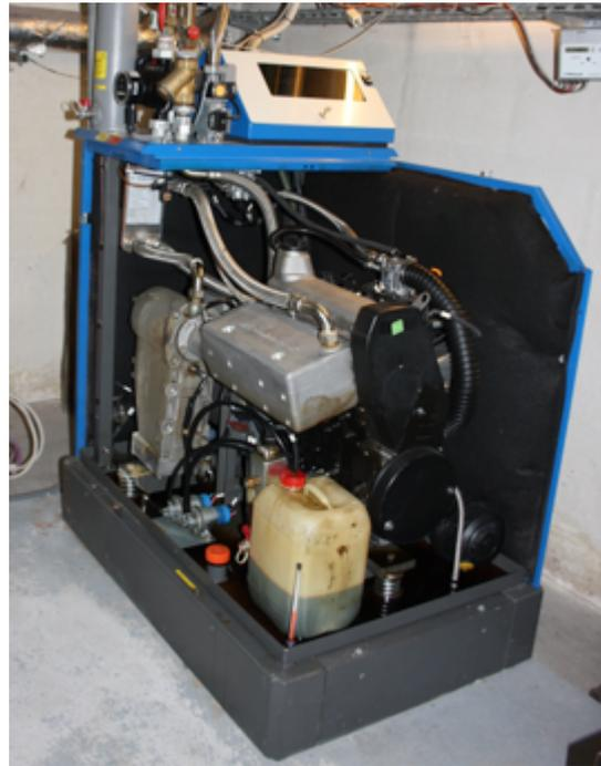
Kraft-Wärme-Kopplung (KWK) beschreibt Prinzip - gleichzeitige Produktion von Kraft (Strom) und Wärme
